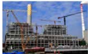
建筑施工噪声 Construction Noise
